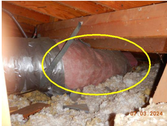
Torn vapor barrier
