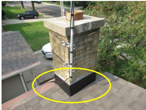
flashing&gt;chimney
